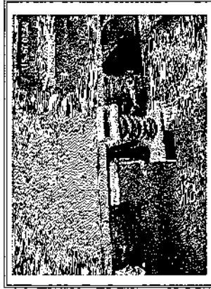
รูปที่ 3.1 ติดตั้งตัวเก็บเสียง (Silencer) เพื่อลดระดับความดังเสียง และสปริงลดแรงกระชอนใช้ลดแรง กระแทกของเครื่องจักร
