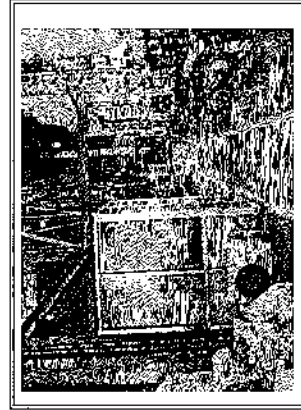
รูปที่ 3.1 ติดตั้งตัวเก็บเสียง (Silencer) เพื่อลดระดับความดังเสียง และสปริงลดแรงกระชอนใช้ลดแรง กระแทกของเครื่องจักร
